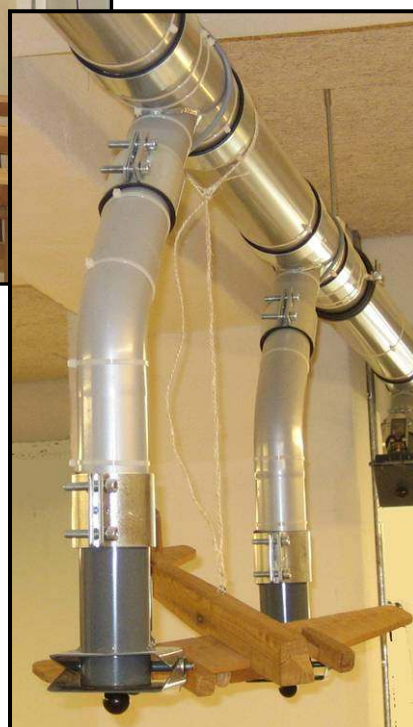
Lofthængt punktudsugning for rengøring af høvlebænk, Valby skole
